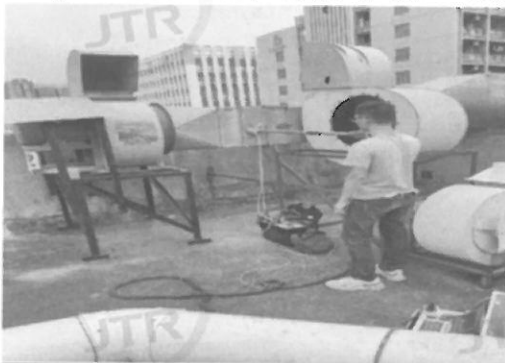
A、QUSA 弯管、密封工序废气监测口 (2#)
